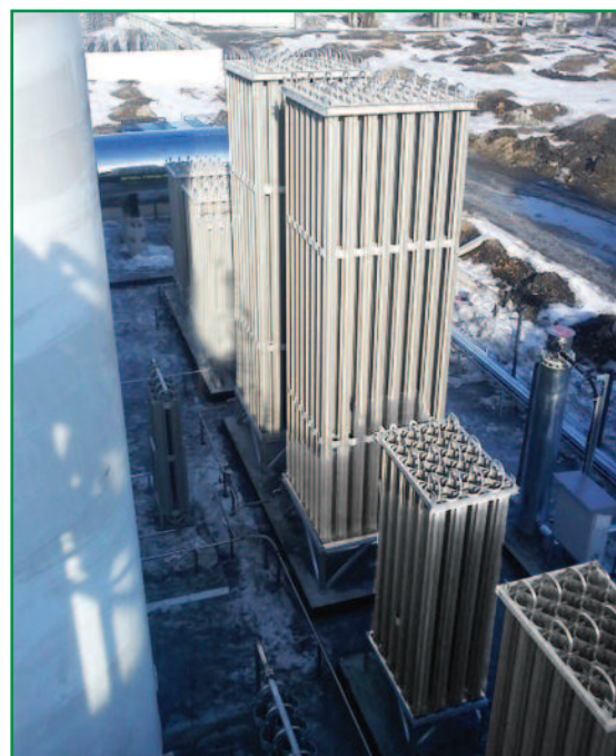
Фото 4. Испарители ИС 0280-С, ИС 1500-С, ИС 0430-С системы хранения и газификации аргона, азота, кислорода (ООО «БВК», г. Челябинск)
