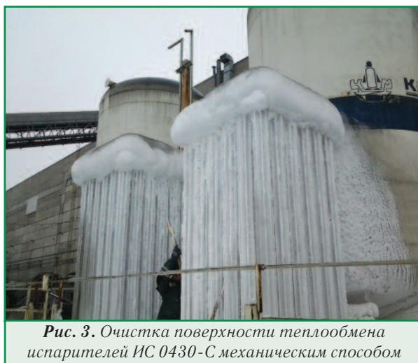
**Рис. 3.** Очистка поверхности теплообмена испарителей ИС 0430-С механическим способом
