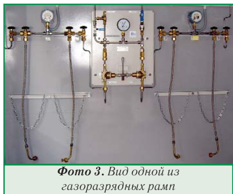
Рис. 2. Разрядная рампа для инертных газов и кислорода с одной ветвью
