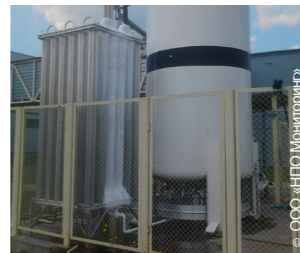
Испаритель ИС 0430-С в составе системы хранения и газификации азота на заводе «Мишлен»
